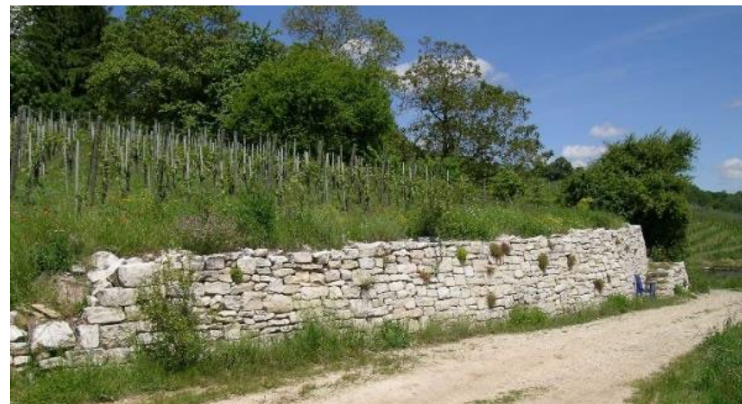
Murs de pierres sèches
